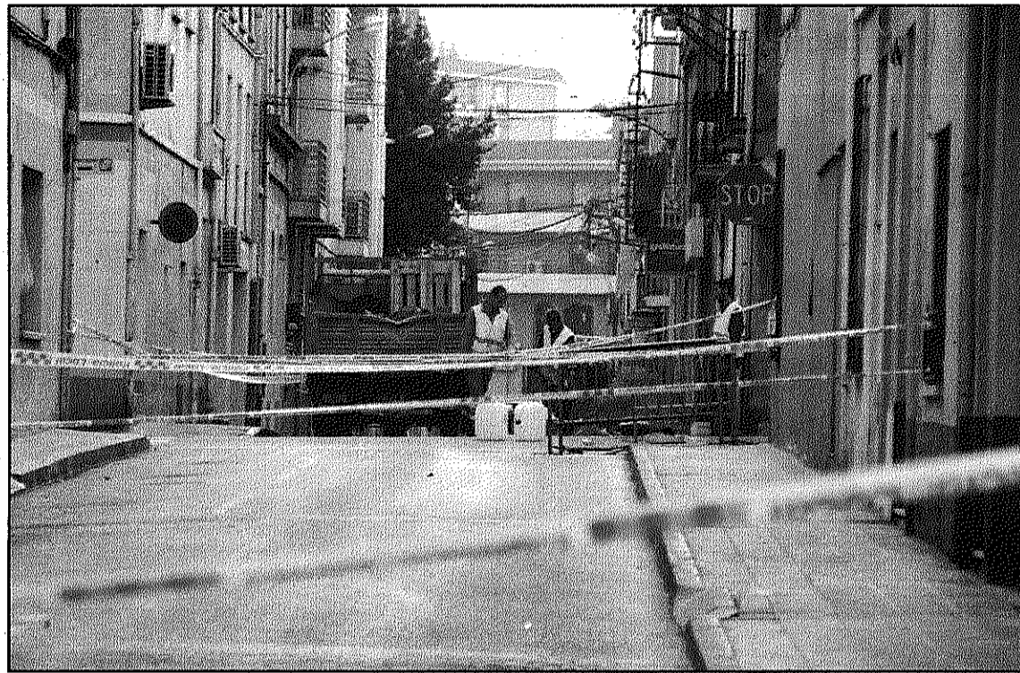
La fuga de gas va afectar diversos carrers i comerços del centre de la vila (L'AdBM)
