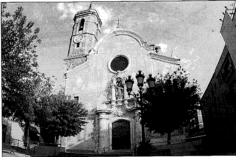
Fecsa reconeix que el transformador de la plaça de l'Església no té prou capacitat (JORDI JIMÉNEZ)
