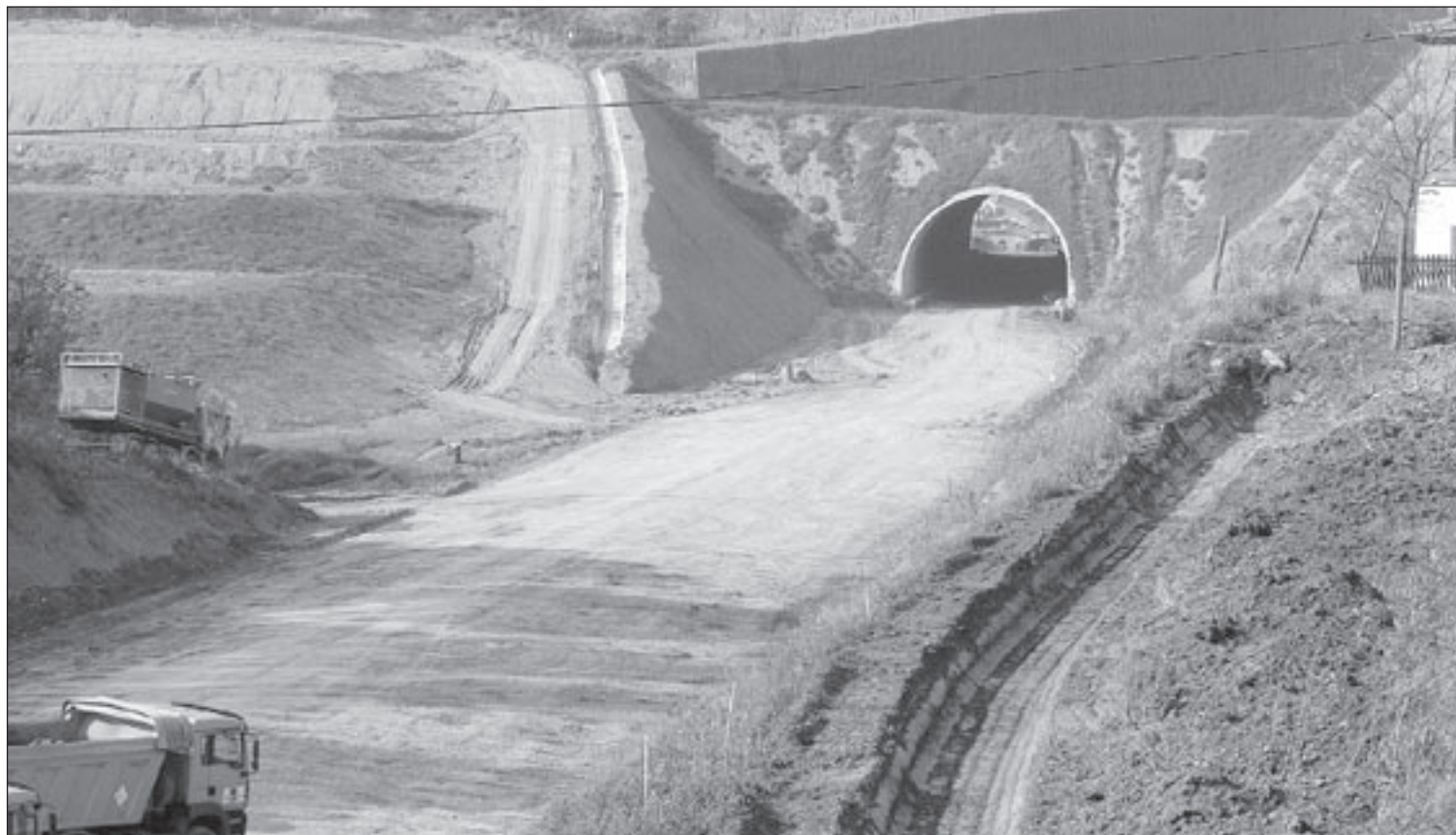
La plataforma del tren d'alta velocitat ja és molt visible en el traçat entre la Roca i la Batllòria. A la imatge, un tram en obres a Palautordera
