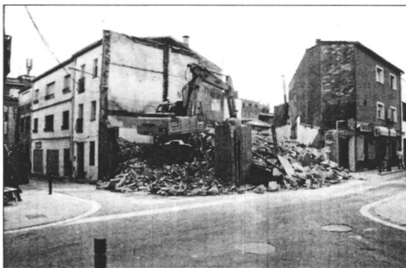
Una imatge de les obres d'enderrocament d'un edifici a la carretera Vella d'ADRIÀ
