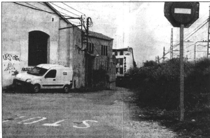
La zona on s'ha de fer el túnel no mostrava cap moviment aquest dimarts (L'ADBM)
