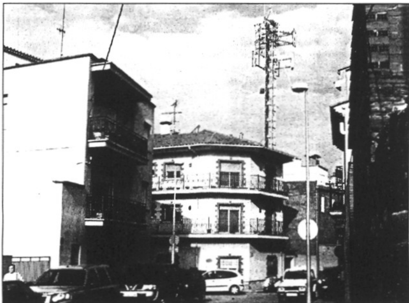
Imatge d'arxiu de l'antena de telefonia mòbil de Telefònica al carrer Jaume I (L'ARIBM)
