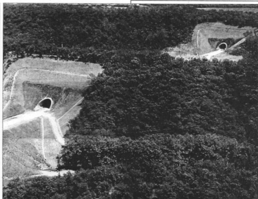
▶▶ Dos túnels travessen turons entre Llinars i Sant Celoni, on la plataforma de la via ja està quasi a punt.
