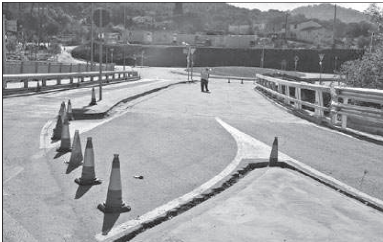
L'ampliació del pont i la nova rotonda donen més seguretat a conductors i vianants
